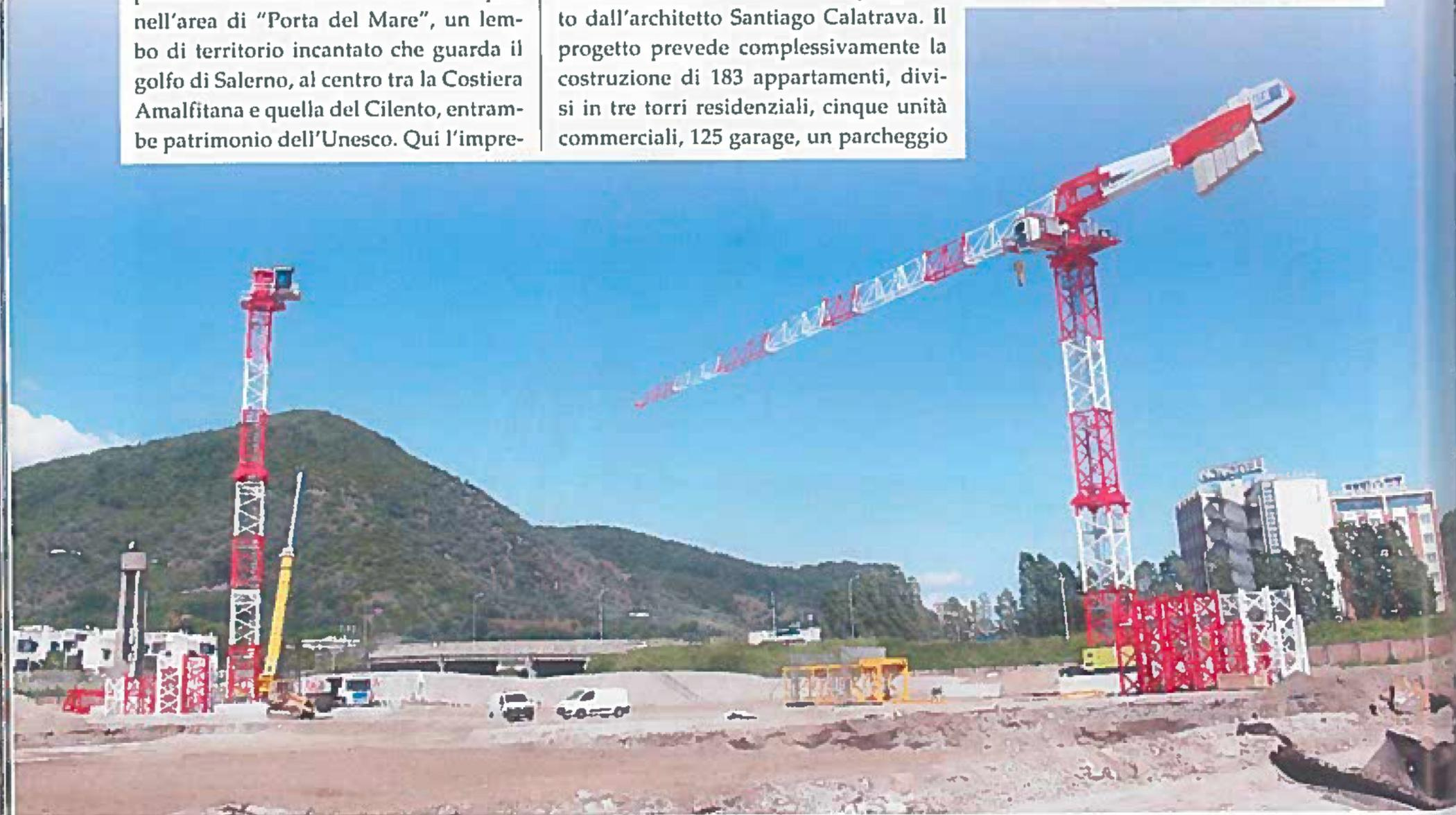
80 m - sono state acquistate da R.C.M. Costruzioni direttamente da Manitowoc Cranes mentre il montaggio e il servizio post-vendita sono stati forniti dal centro assistenza di Edilcom. Le due gru MDT 319 sono state montate alla fine di maggio, in soli cinque giorni, con l'ausilio di un'autogrù della stessa famiglia Manitowoc, una Grove GMK6400 della flotta Pergamo Sollevamenti.
